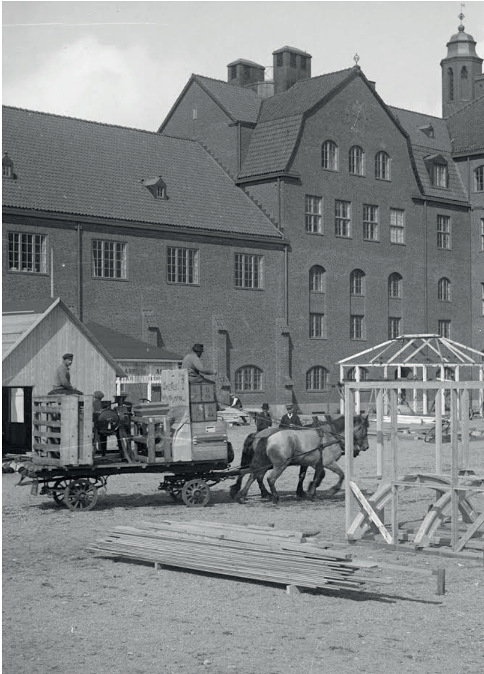
Skolbyggnaden stod färdigrest 1917 men eleverna fyllde inte upp den förrän 1919.
